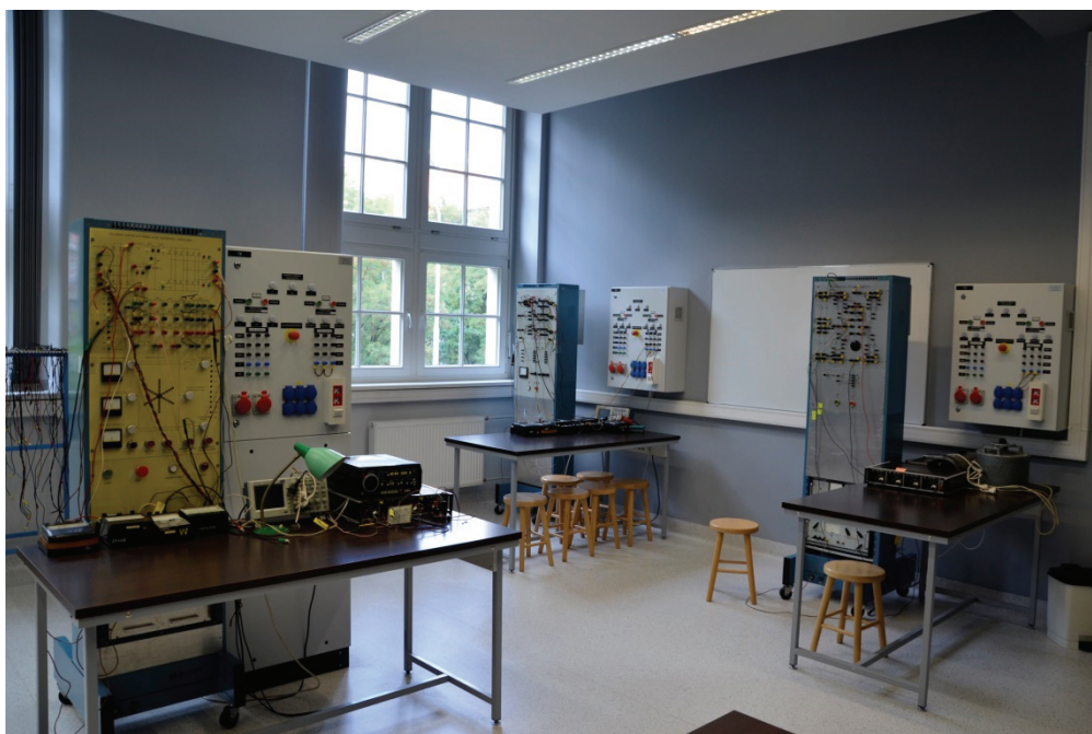
Widok ogólny Laboratorium Energoelektroniki (fot. K. Dyrzcz)
