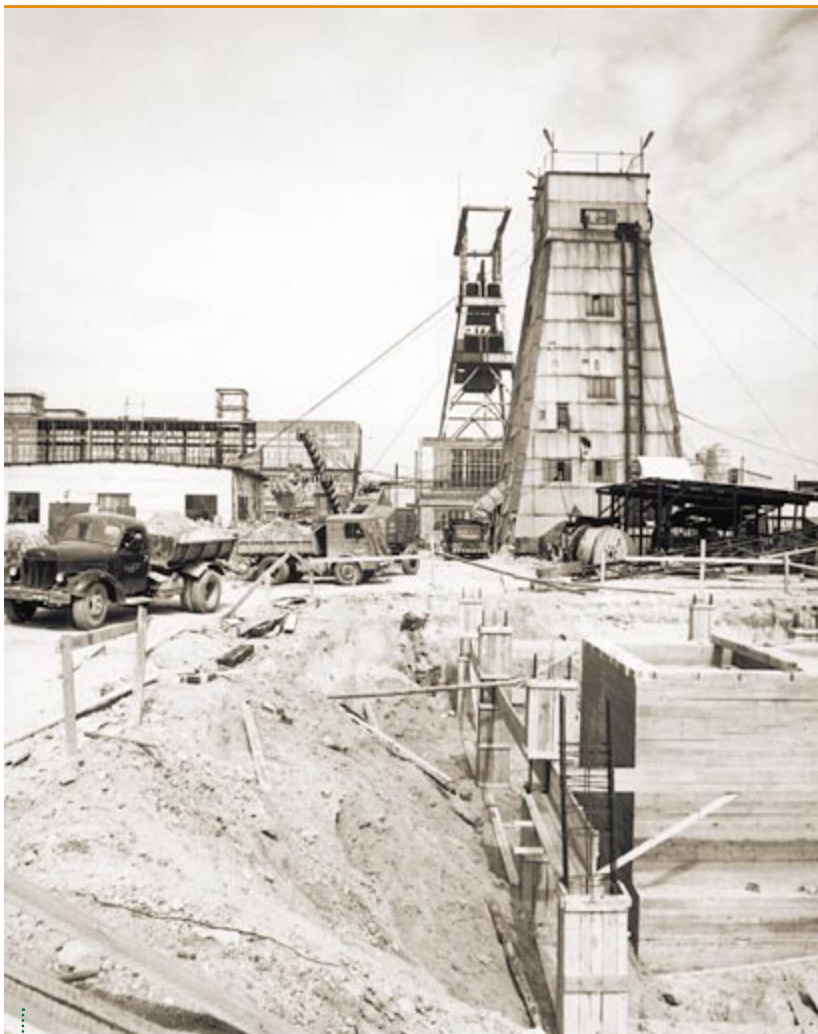
Tak powstawały kopalnie miedziowego zagłębia
